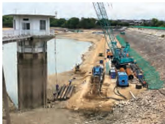
三好池堤体耐震補強工事鋼管杭圧入状況
