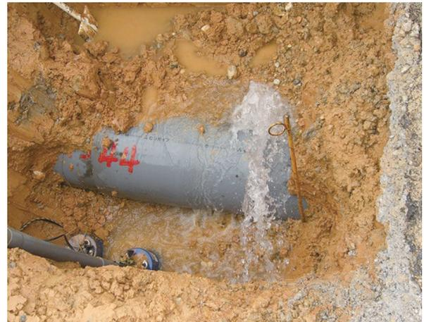
金山支線漏水状況（常滑市）
