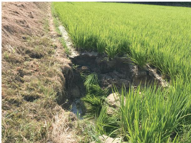
三好支線漏水による陥没（みよし市）
