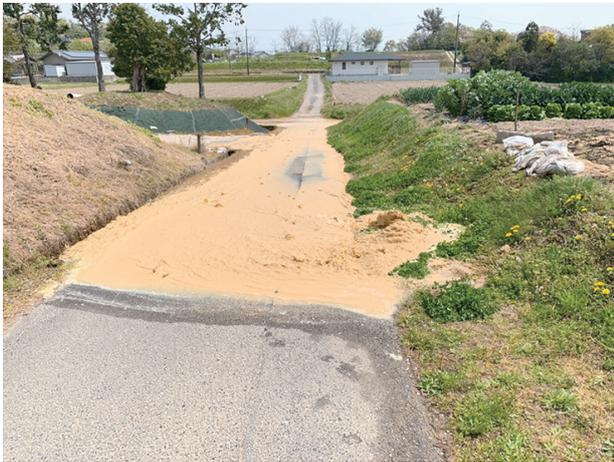
三好支線漏水発生状況（みよし市）
