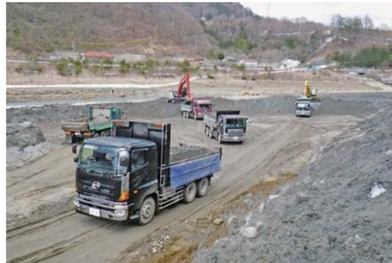
2号貯砂ダム下流部土砂掘削搬出状況（H27.3）
